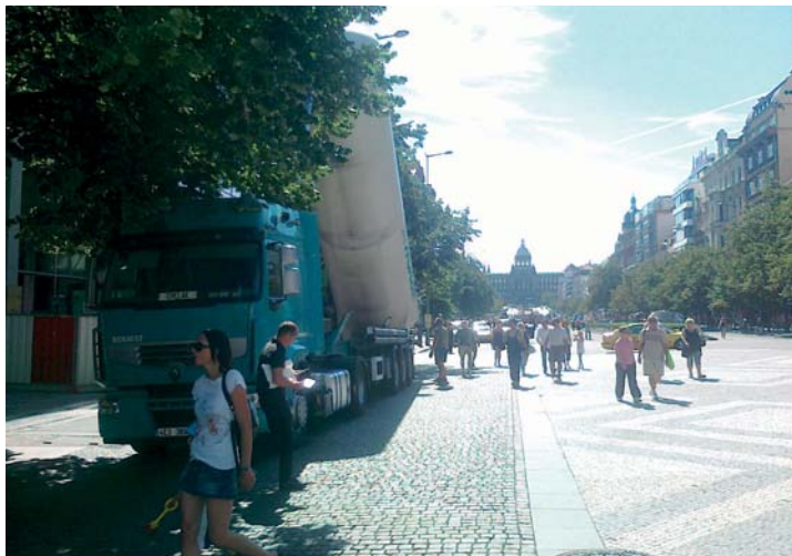
Foukání střešního substrátu do atrii budovy Diamant na Václavském náměstí v Praze
