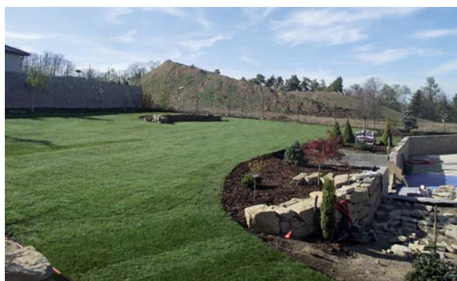
Hotová realizace firmou ing. Marciána
