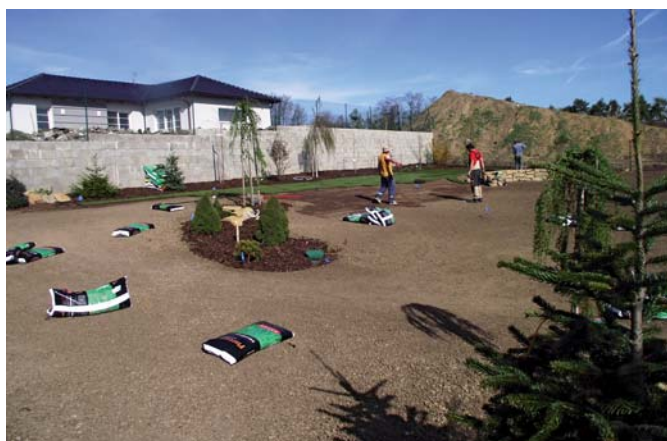
Příprava povrchu pro pokládku travního koberce
